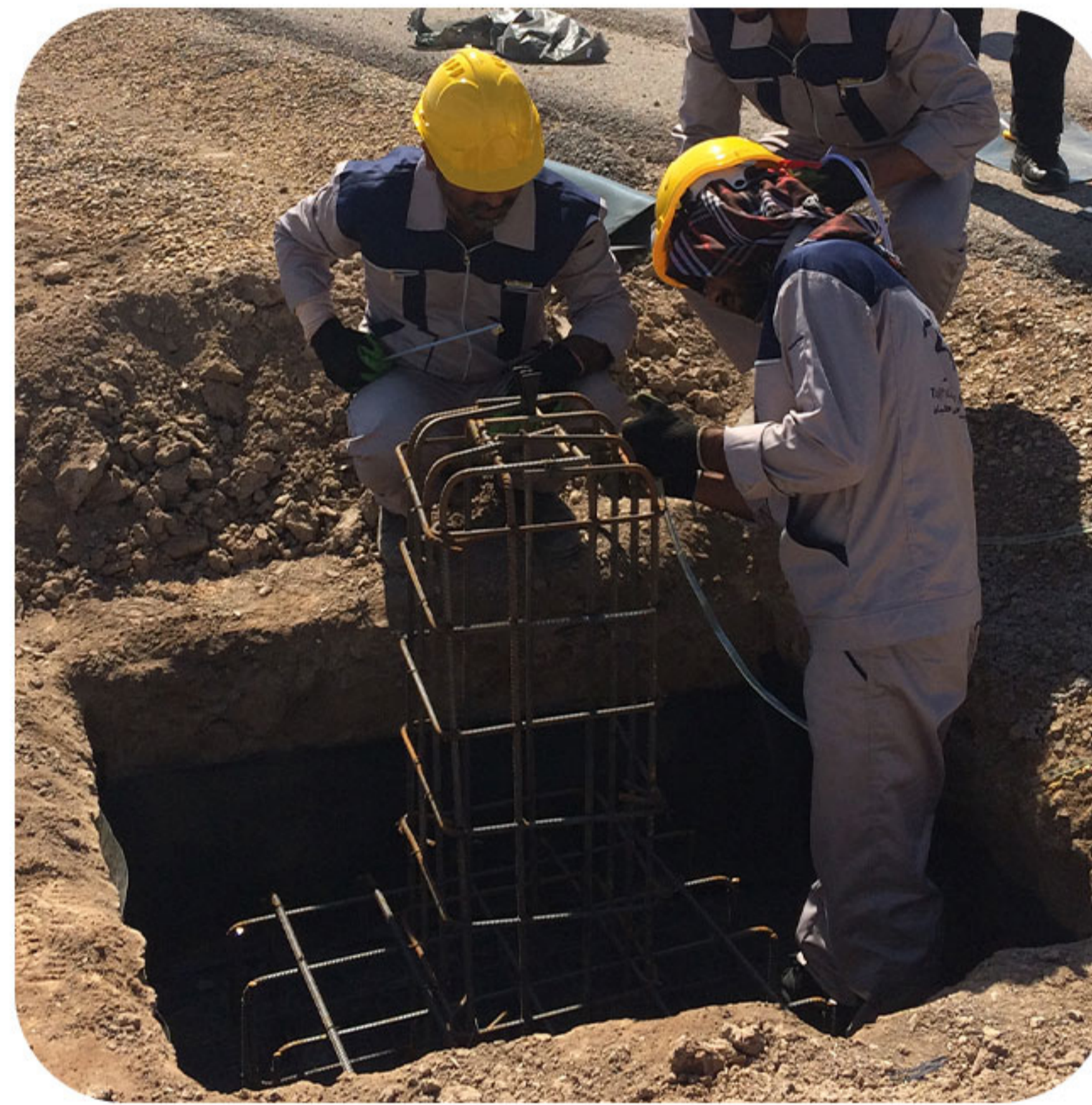
اجرای فونداسیون، آرماتوربندی، بتن ریزی و نصب و راه اندازی چراغ های خیابانی جاده دسترسی ایستگاه گاز شلمچه.
