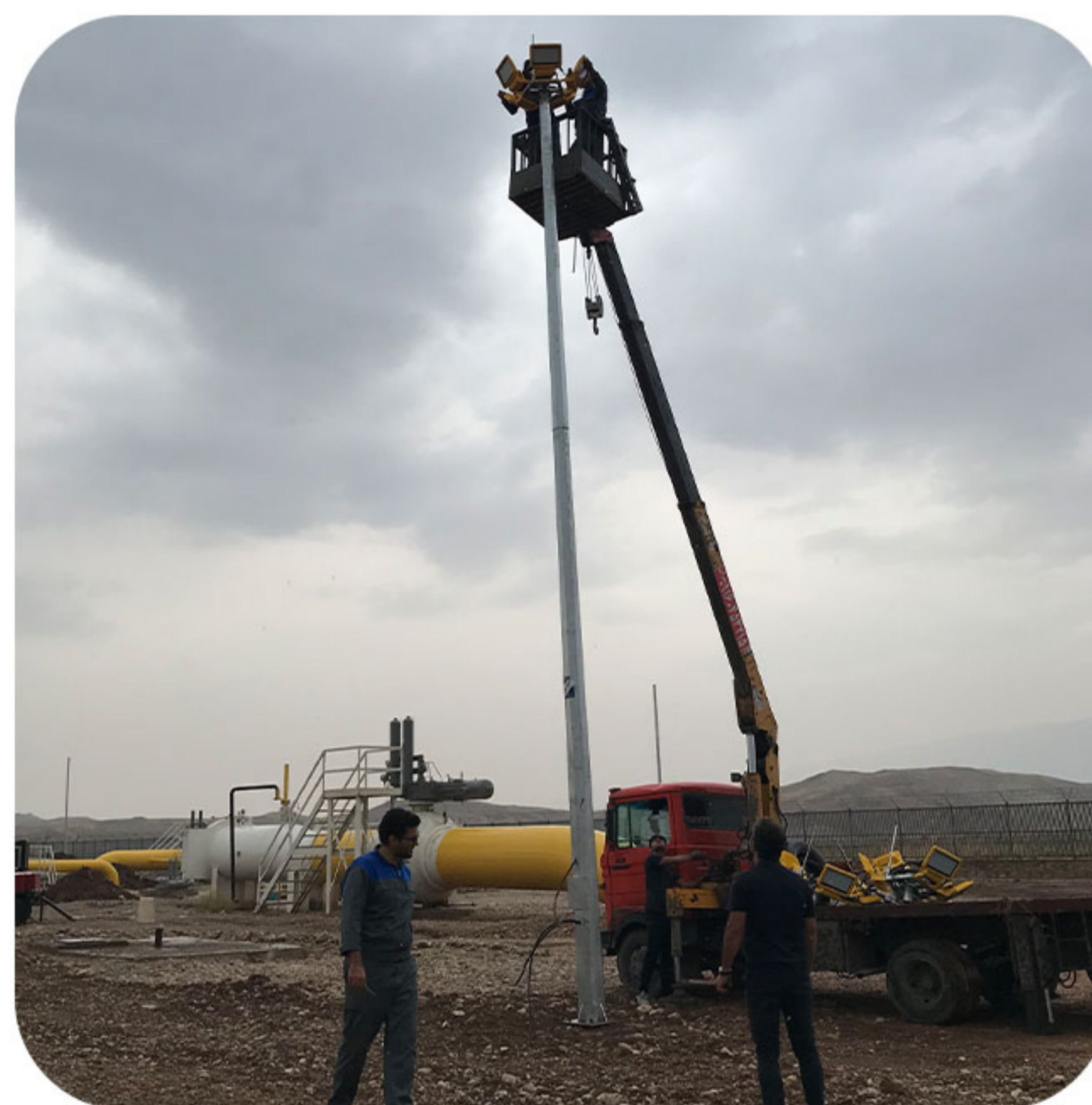
طراحی و اجرای سیستم روشنایی ضد انفجار ایستگاه های گاز واقع در استان های ایلام و کرمانشاه.
